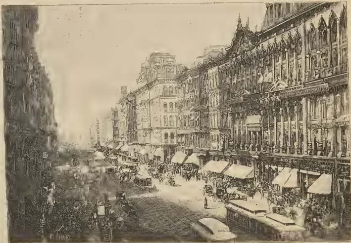
Fig. 2 - State Street, en Chicago. (De una fotografía.)
